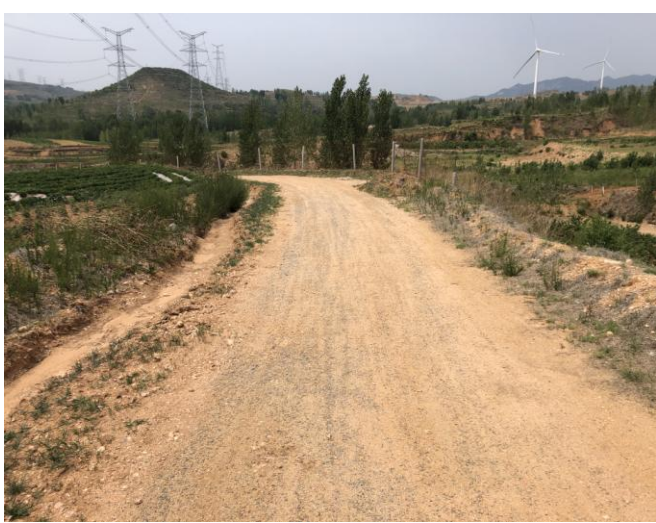
路面碎石防护和土质排水沟
