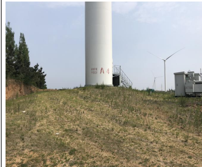
#A4 风机平台植被恢复
