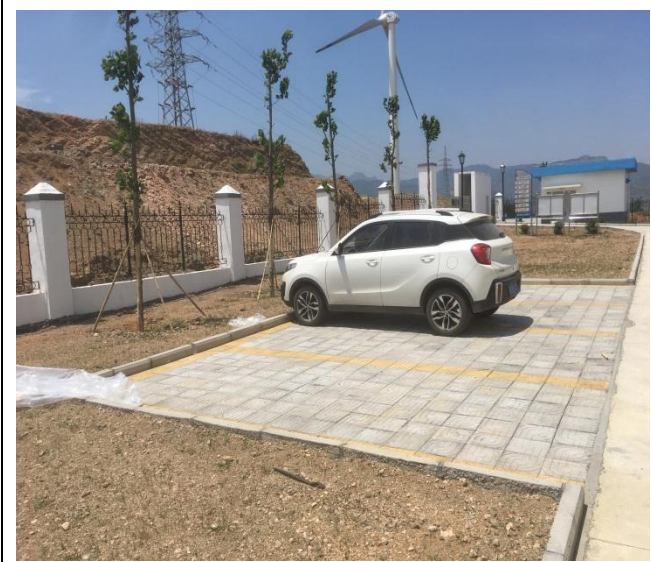
升压站内透水砖措施
