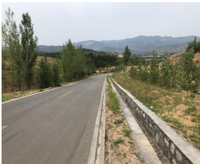
道路一侧浆砌石排水边沟
