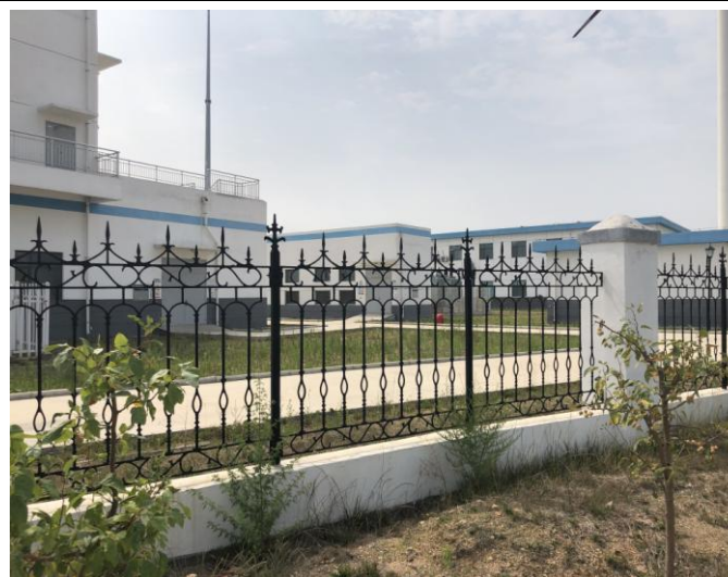
升压站内绿化措施
