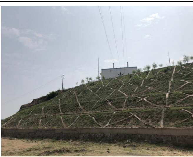
升压站外西侧综合护坡
