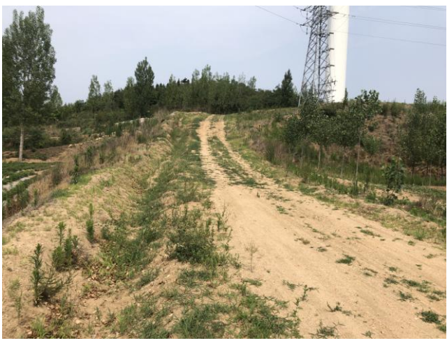
#A6 风机平台进场路
