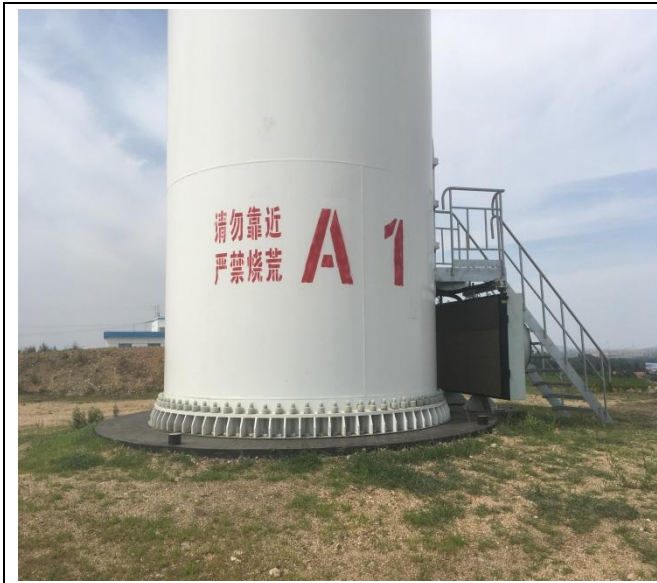
#A1 风机平台植被恢复
