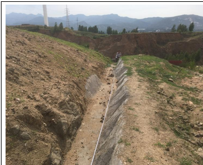
升压站外南侧截水沟
