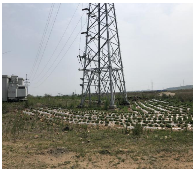
塔基植被恢复及复耕
