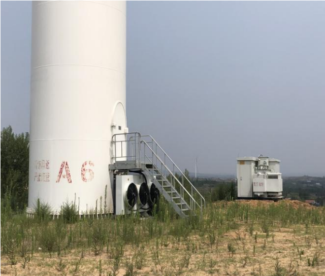
#A6 风机平台植被恢复
