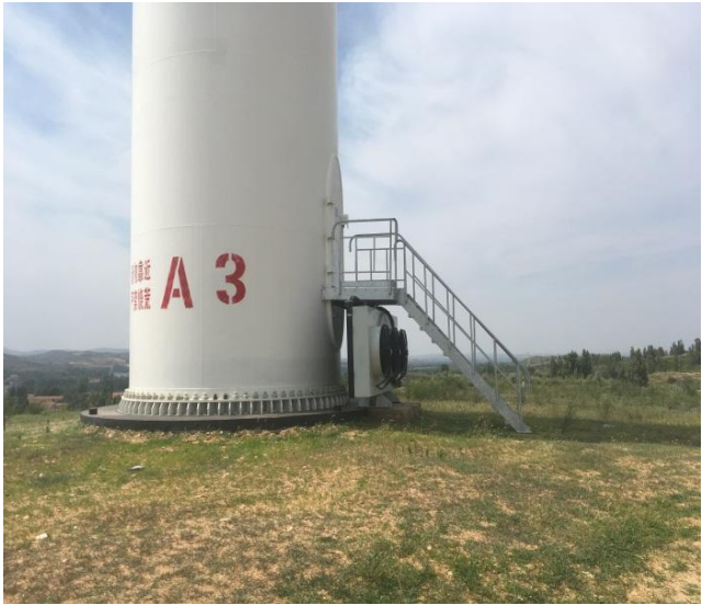
#A3 风机平台植被恢复
