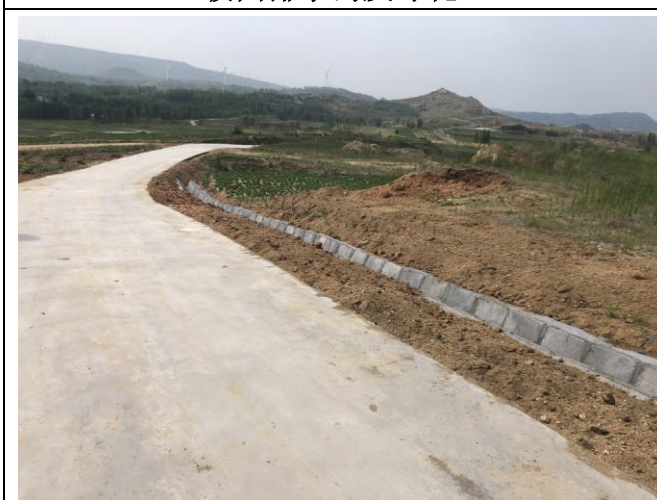
升压站进站道路 U 型排水槽
