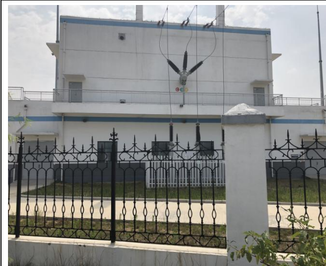
升压站内绿化措施
