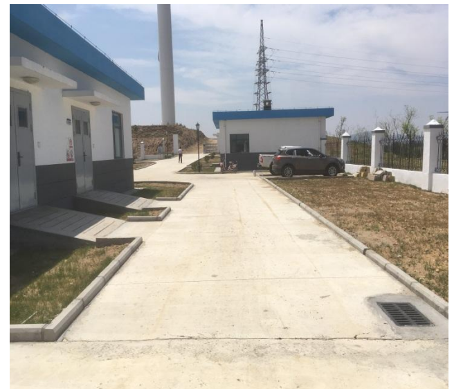
升压站内排水及绿化措施
