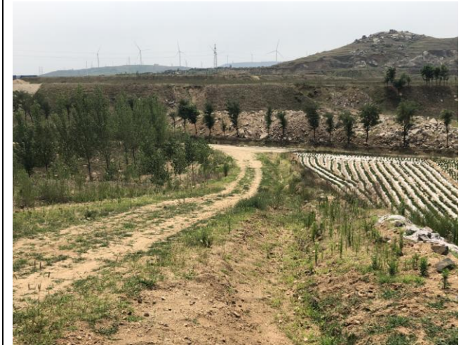
#A4 风机平台进场路
