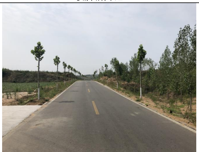
升压站进站道路及绿化
