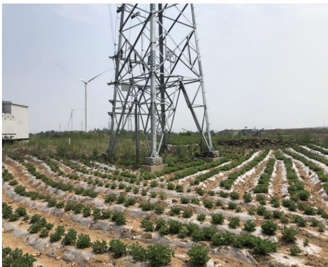
塔基植被恢复及复耕
