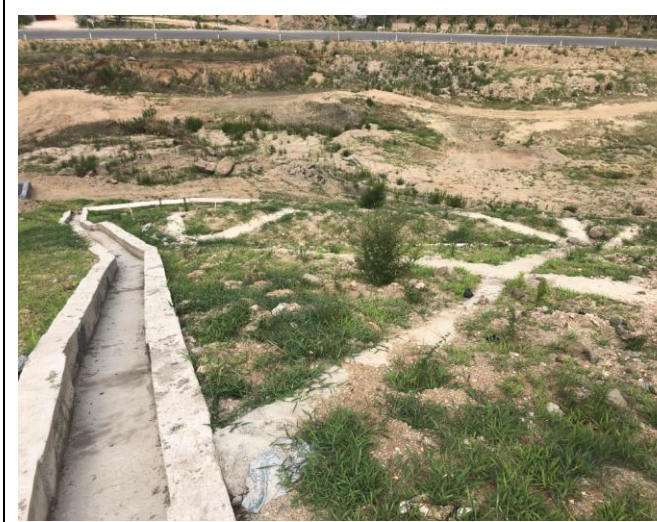
坡面排水沟及绿化
