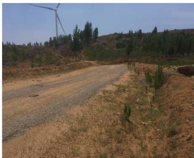
路面碎石防护和土质排水沟
